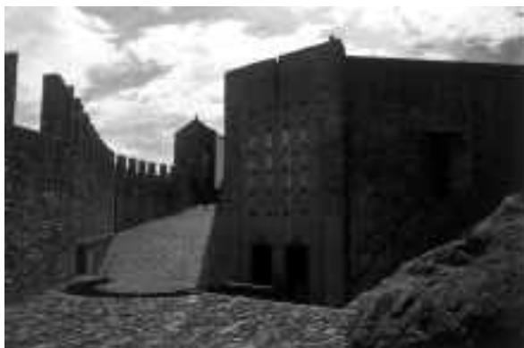
Accès ascenseurs niveau château, Parc de Castelgrande, Bellinzona, arch. Aurelio Galfetti, 1983-1991 - photo J. Sordollet
