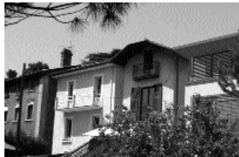
Extension contemporaine à Caluire. Arch. Pierre Faure. 2003.
