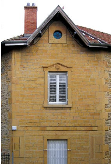
Rue de la République : pan coupé en pierre appareillée © CAUE du Rhône
