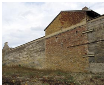
Parcours industriel, Vaise © CAUE du Rhône
