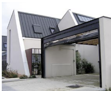
Hauts de Feuilly, Tekhné - © CAUE du Rhône
