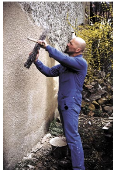
Démonstration de jets au balais par Jean-Jacques Algros, Ecole d'Avignon, centre de formation à la réhabilitation du patrimoine architectural © CAUE du Rhône
