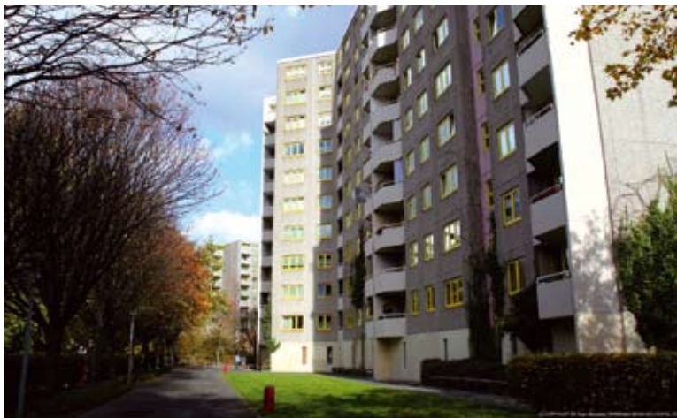
Wohnhausgruppe 917, Die Gebäudegruppe an der Treuenbrietzener Strasse und Quickborner Strasse : 750 appartements. Architect: Volker Theißen / René Gagès.
