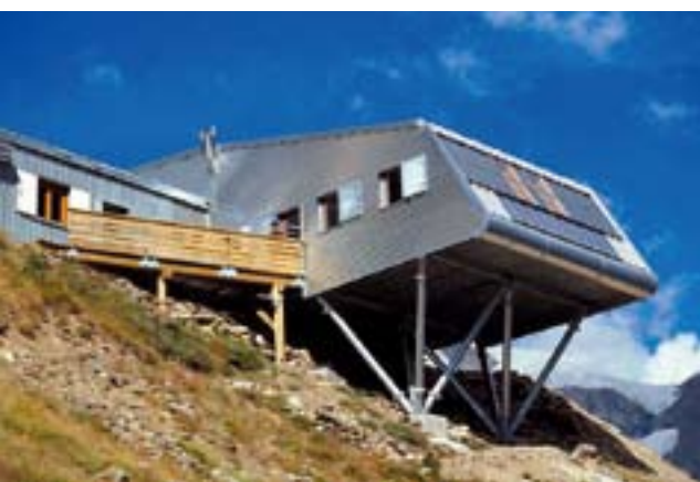
Refuge de la Selle, 2672 m d'altitude. Massif des Ecrins, Saint-Christophe-en-Oisans (Isère) Grand refuge à ossature héliportée, autonome en énergie, tout en un maçonné. Deuxième extension de 1996 sur un refuge à l'origine de 1878.
