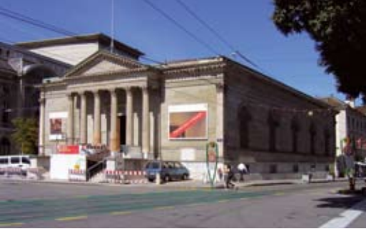
Genève : chantier du Musée Rath (1826), classé monument historique. Réhabilitation avec ventilation double flux.
