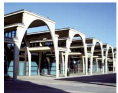
Umberto Cuzzi, Marché horticole de Turin (1932), rénovation par AIA Atelier de la Rize (2006) © CAUE du Rhône.
