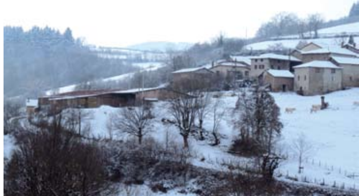
Commune de Trades, bâtiment d'élevage au hameau de Chambosses
