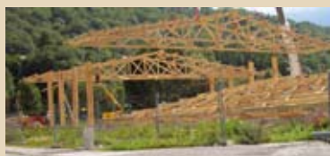
Ferme Ariane en bois, 27 mètres de portée, avant-toit de 7 mètres, pont roulant sur poteaux bois. Maître d'ouvrage : SCI Immotim (Groupe CBS-CBT). Architectes : R. Amiot & V. Lombard ; © cbs-cbt.
