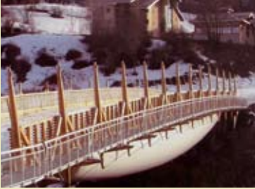
Un pont en première mondiale.
