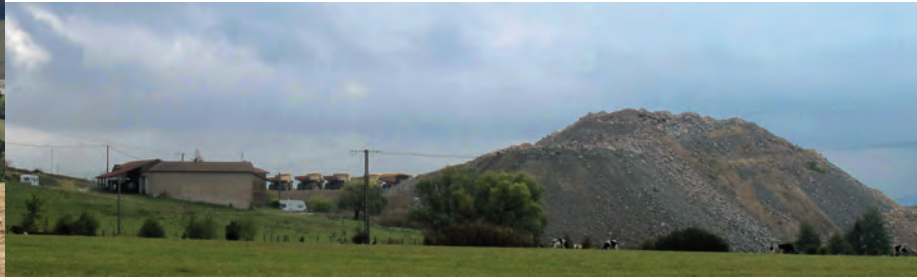
Chantier de l'A89 sur la commune des Olmes @ CAUE69
