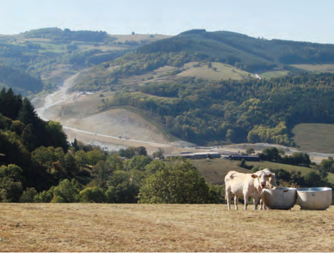
Chantier de l'A89 dans les monts pâturés de Tarare sur la commune de Saint-Marcel-l'Éclairé
