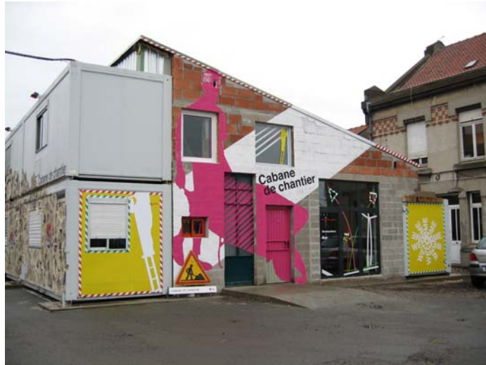
Chantier du Channel à Calais (Pas-de-Calais)
